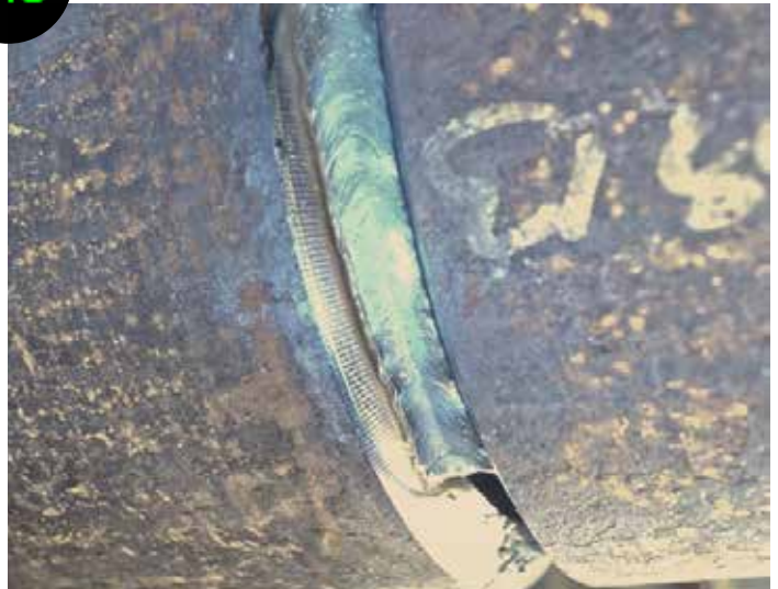
IAC™ – Lodrät fallande svetsning av ett rotsträng i en fjärrvärmelledning. Svetshastigheten ökas betydligt jämfört med traditionell stigande svetsning.
